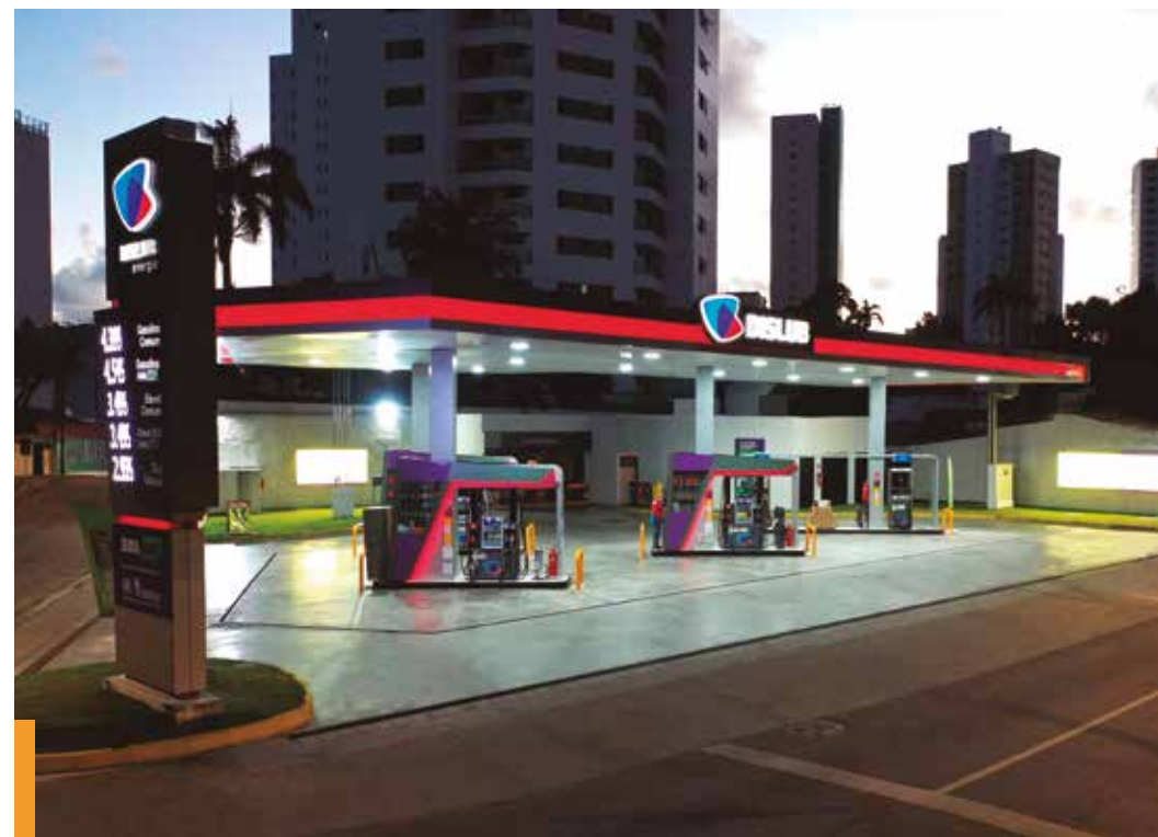
Posto Dislub AV Combustíveis (Recife - PE)
