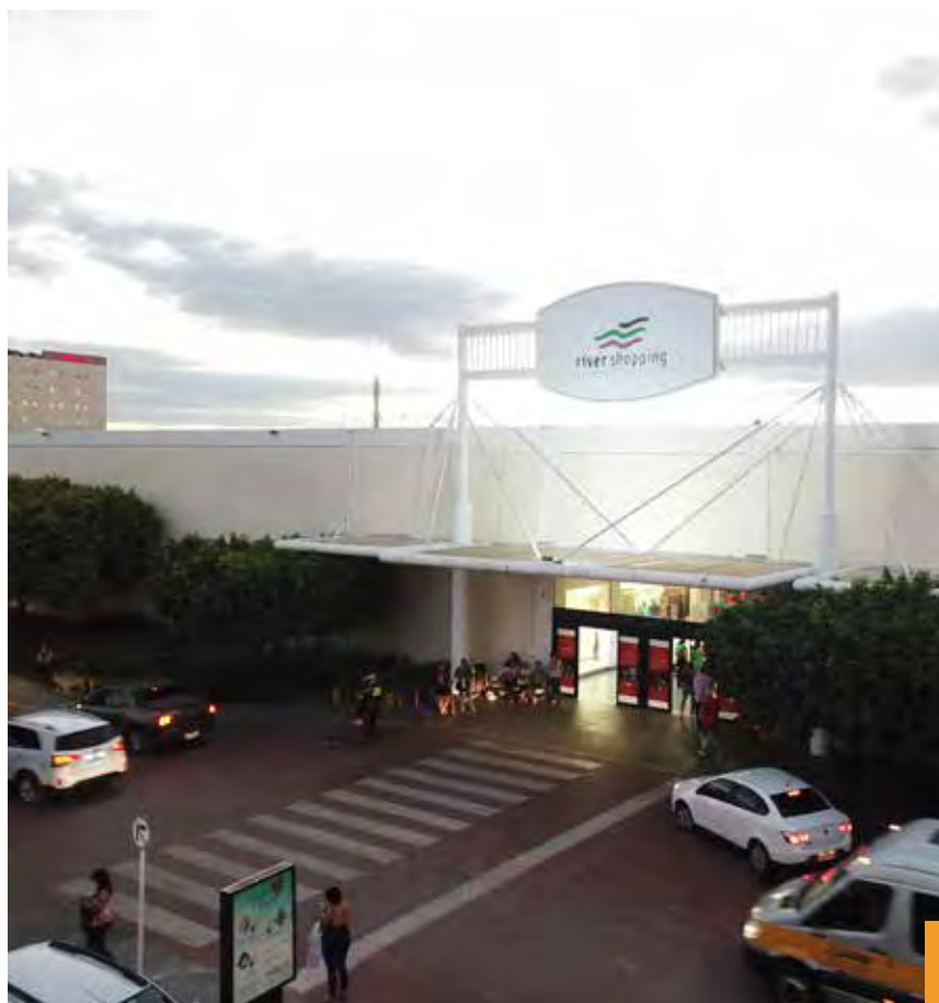
Fachada do River Shopping, em Petrolina
