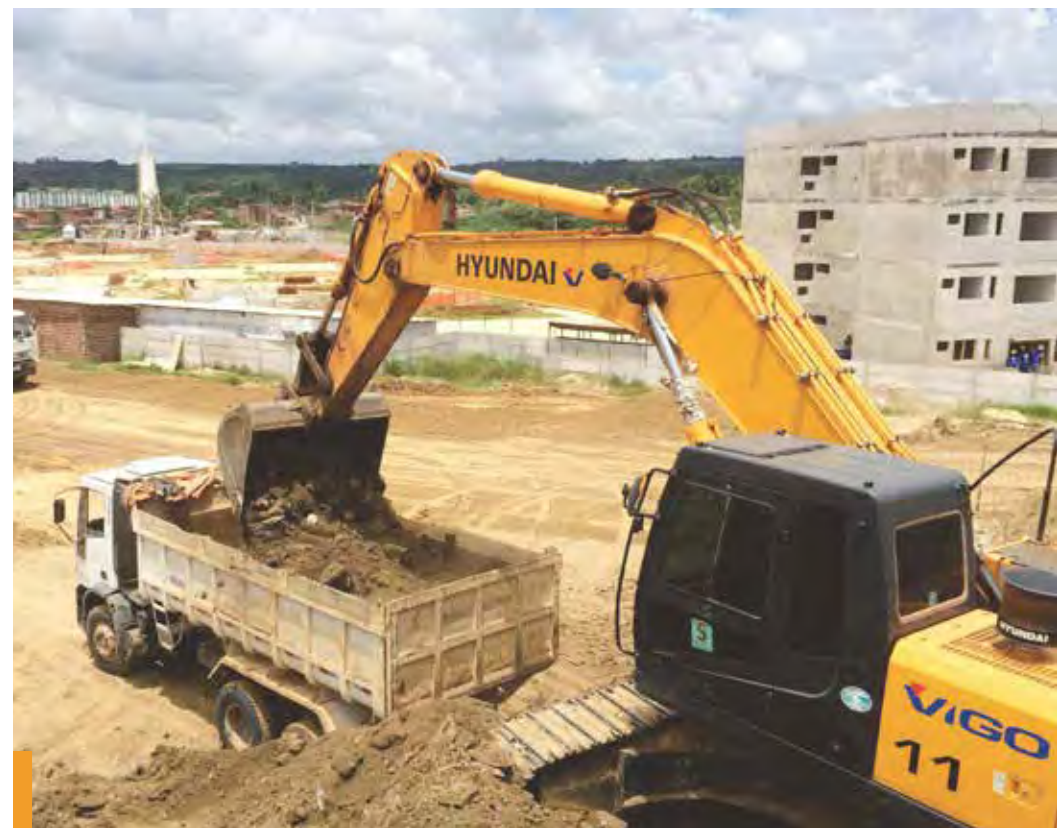
Serviços de Terraplanagem em São Lourenço da Mata - PE
