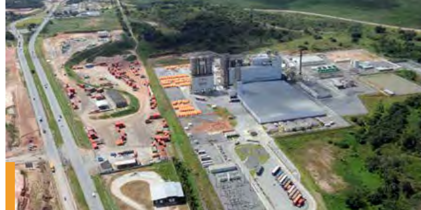
A maior fábrica de resina PET do mundo foi construída pela Pernambuco Construtora
