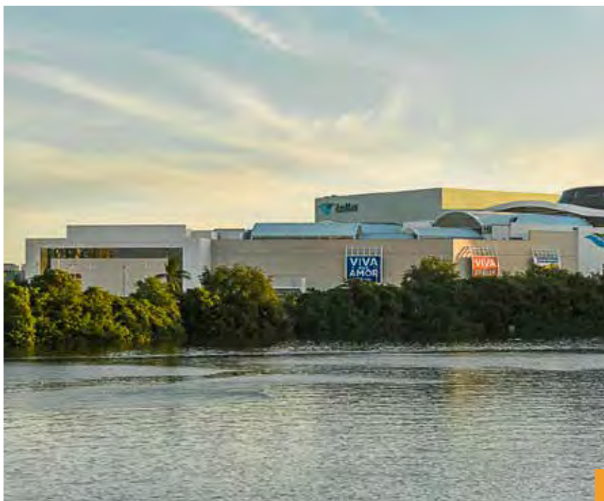
Localizado estrategicamente entre as zonas norte e sul da cidade do Recife
