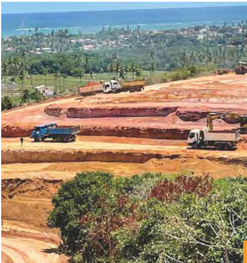
Serviços de terraplanagem de um Loteamento em São José da Coroa Grande
