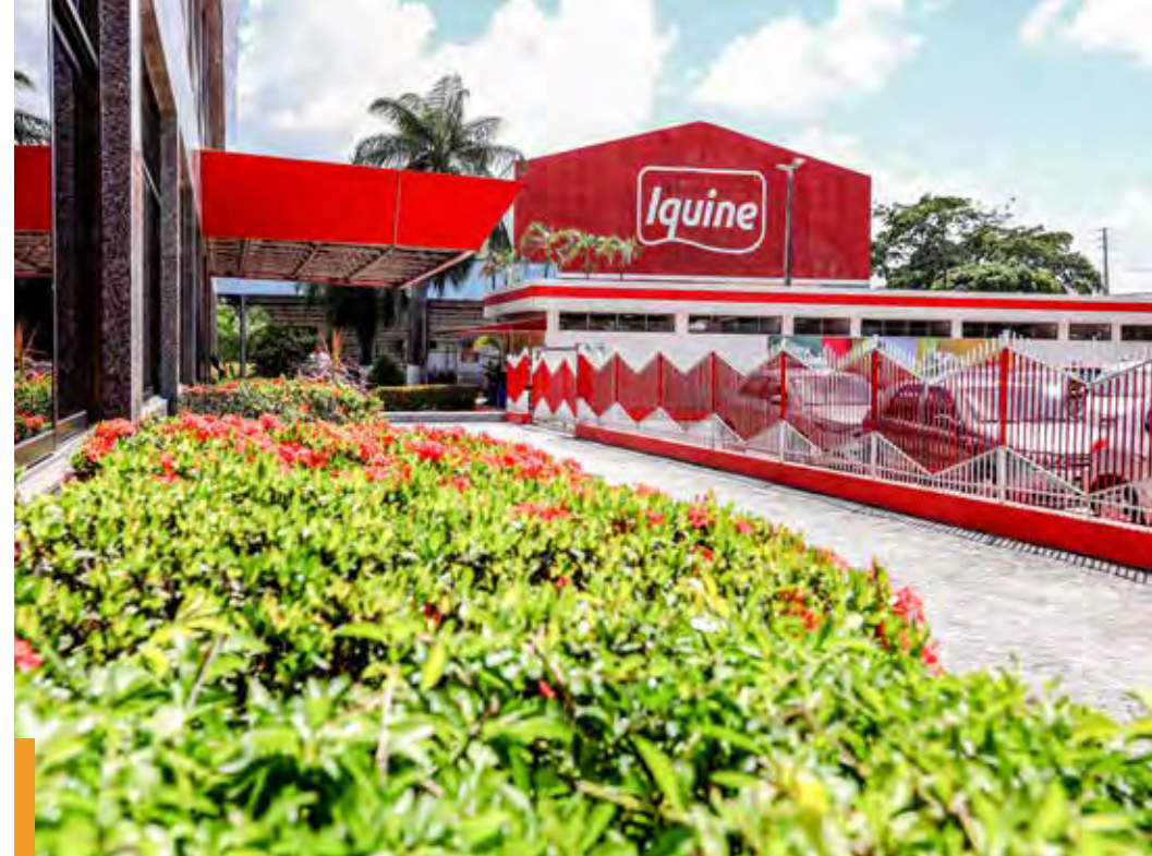
Vista da entrada de uma das plantas do Grupo Iquine, localizada em Jaboatão dos Guararapes (PE)
