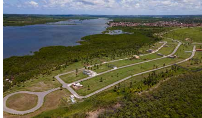
Terranorte Urbanismo, empresa do grupo especializada em loteamentos
